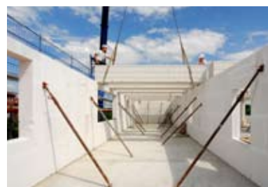
Mauertafeln werden entsprechend der individuellen Planung exakt nach Maß gefertigt. Die computergesteuerte Produktion garantiert eine zuverlässig hohe Mauerwerksqualität.
