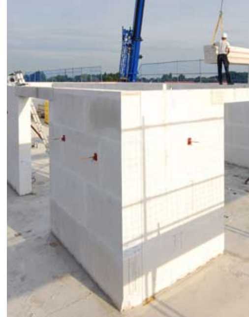
Durch Mauertafeln aus Porenbeton konnte der Bauablauf optimiert und die Bauzeit verkürzt werden.
