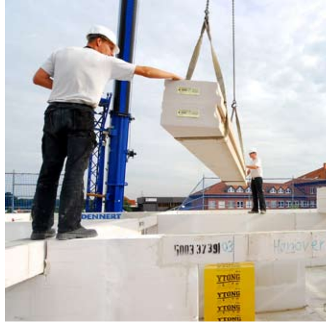
Das Ytong Massivdach bietet sommerlichen Wärmeschutz und verhindert ein übermäßiges Aufheizen des Gebäudes durch die Sonneneinstrahlung.
