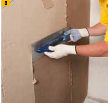
Aufziehen des Oberputzes
