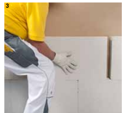
Ytong Multipor Mineraldämmplatten an der Wand einschwimmen...
