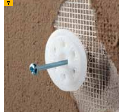
7 Setzen des Dübels durch das Gewebe
