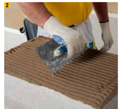
Aufkämmen des Ytong Multipor Lehmörtel
