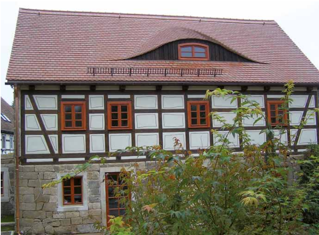
Von innen gedämmtes Fachwerkgebäude in Pirna-Bonnewitz (Sachsen)
