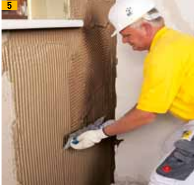
5 Armierungsschicht auftragen
