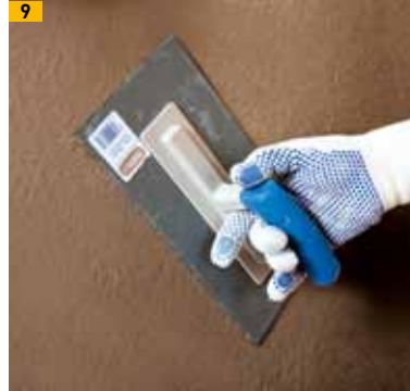
Strukturieren mittels Traufel
