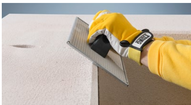
Anfasen der Steinkante am Deckenauflager
