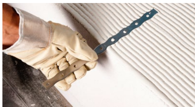
Mauerverbinder einlegen
