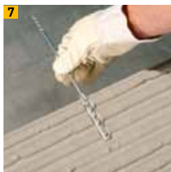
7 Luftschichtanker zum Einlegen
