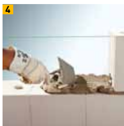
4 Normalmörtelauftrag auf die Lagerfuge mit Kelle
