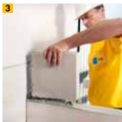
3 Auftrag Silka Secure Dünnbettmörtel für Stumpfstoß und Setzen des Steins
