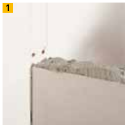
1 Silka Secure Dünnbettmörtel – Lagerfuge
