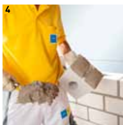
4 Normalmörtelauftrag auf die Lagerfuge
