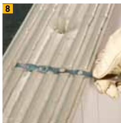
8 Anwendung von Mauerverbindern bei Stumpfstoßtechnik
