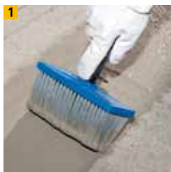
1 Sperrschicht mit Dichtschlämmen
