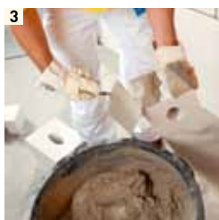
3 Stoßfugenmörtel- auftrag
