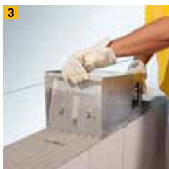
3 Dünnbettmörtelauftrag auf die Lagerfuge mit Mörtelschlitten und Torbogenverzahnung
