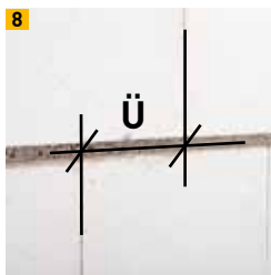
8 Überbindemaß bei Silka Ratio-Blocksteinen \text{Ü} \geq 0,4 \times \text{Steinhöhe}
