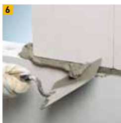
6 Herausquellenden Mörtel abschneiden
