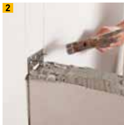
2 Bauplatten Wandanschlussanker
