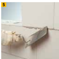
5 Herausquellenden Mörtel abschneiden
