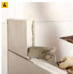
4 Stoßfugenvermörtelung mittels Silka Secure Dünnbettmörtel
