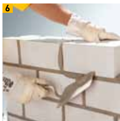
6 Herausquellenden Mörtel abschneiden
