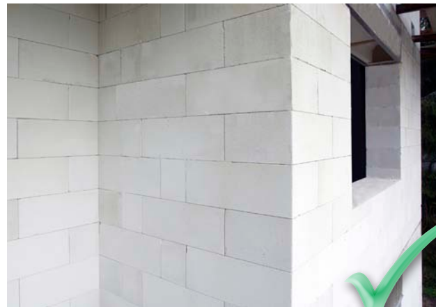
Korrekte Ausführung mit Ytong Eck- und Laibungsstein
